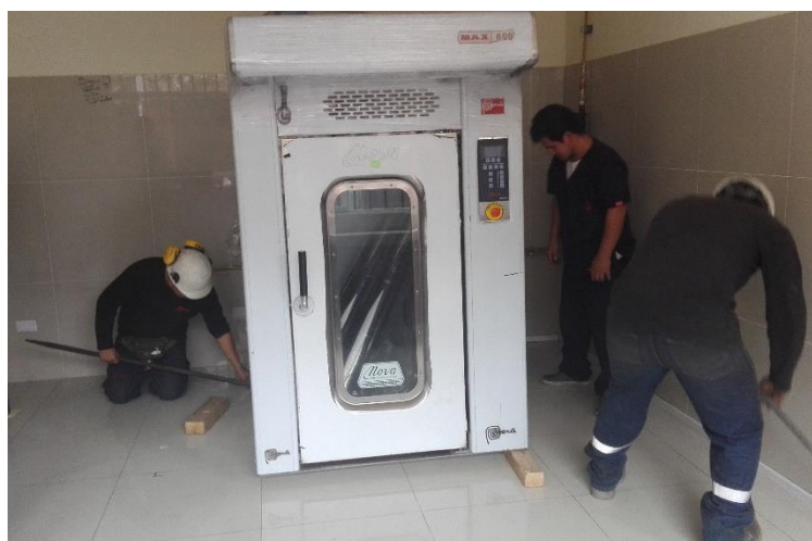
Instalación del horno
