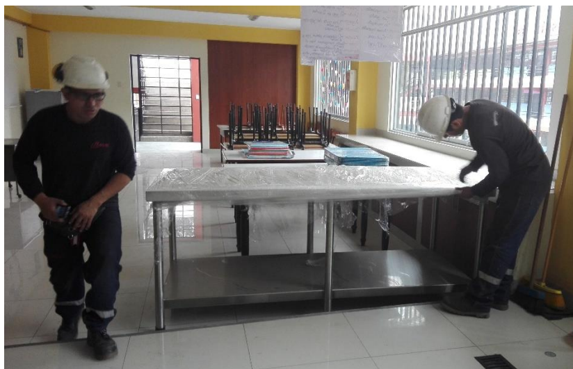
Colocación de la mesa de trabajo
